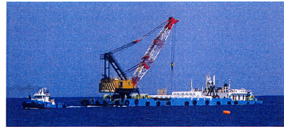
320ps 大幸丸による起重機船曳航作業
