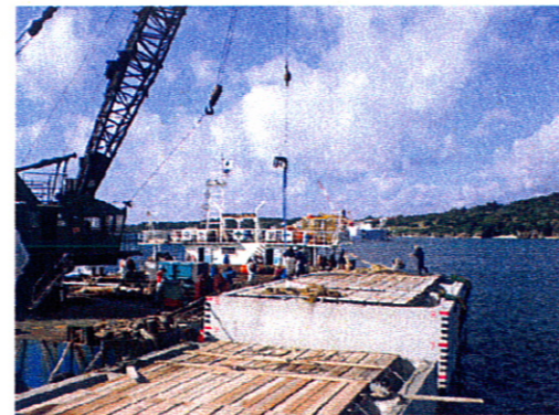
④ケーソン進水に伴う機材設置作業
