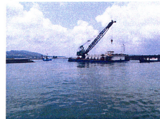
③引船による海上運搬作業
