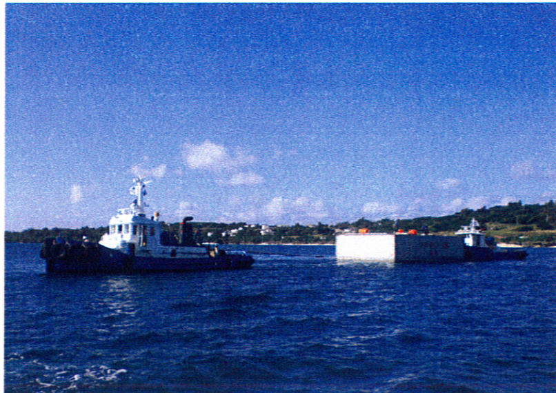
1000ps 第八永見丸及び590ps 第六太誠丸によるケーソン曳航作業
