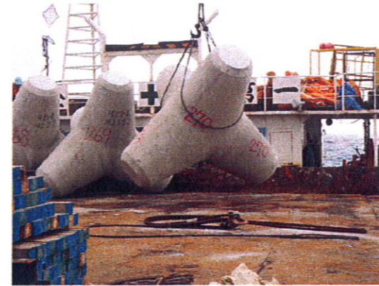
①120t吊第三金剛による積込作業
