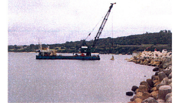
④120t吊第三金剛による海上据付作業
