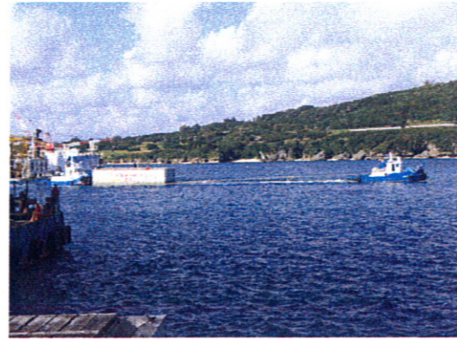
②1000ps引き船によるケーソン曳航作業
