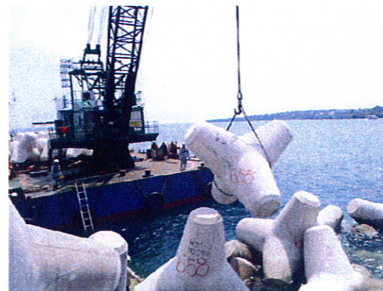
⑤120t吊第三金剛による海上据付作業
