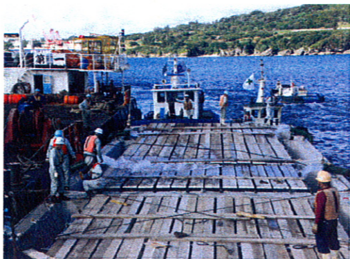
⑤ケーソン進水作業
