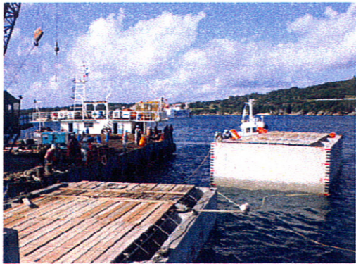
③120t吊第三金剛によるケーソン据付作業
