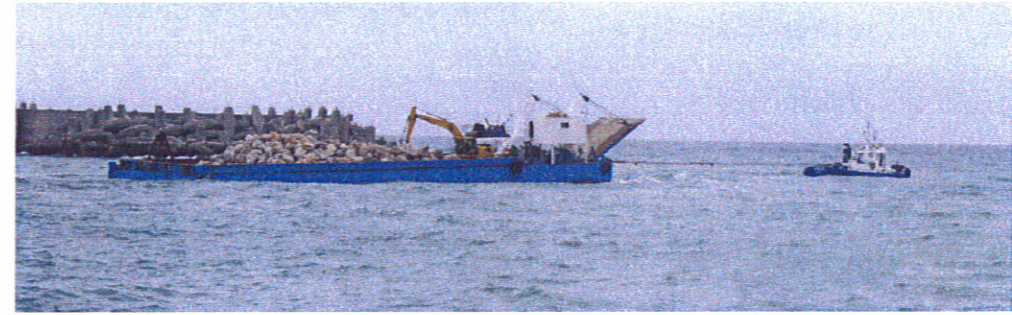
590ps 第六太誠丸による起重機船曳航作業
