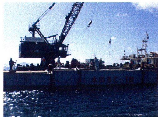
⑥起重機船による位置調整
